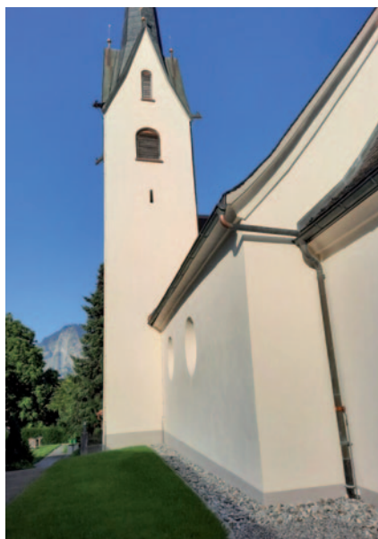
... und nach der Renovation
