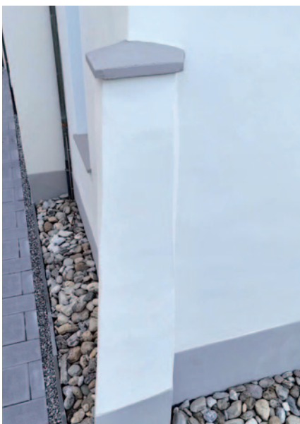
... und nach der Renovation
